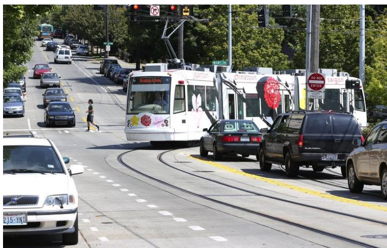
Рисунок 1.1 – Пересечение трамвайных путей с автомобильными дорогами
