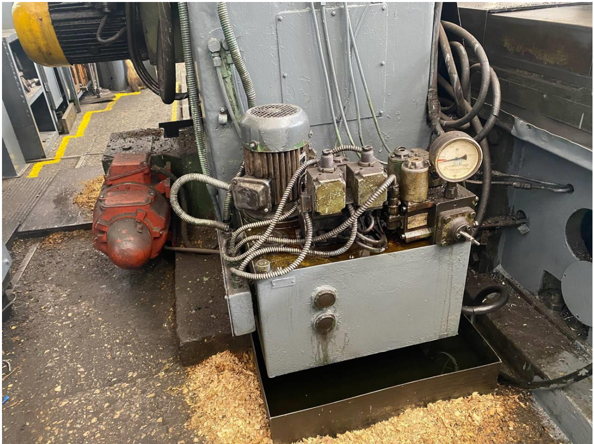
Рисунок 5.2 – Насосная станция продольно-фрезерного станка 6Г610
